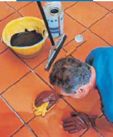
Xử lý gạch cotto toscano trước khi chít mạch
