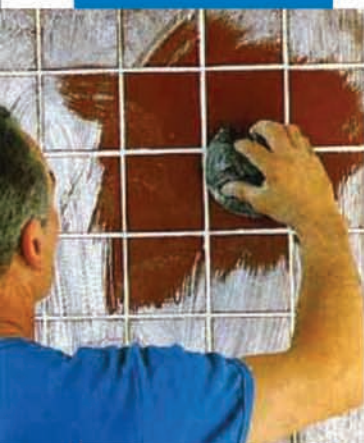
Hoàn thiện mạch chít bằng giẻ sạch
