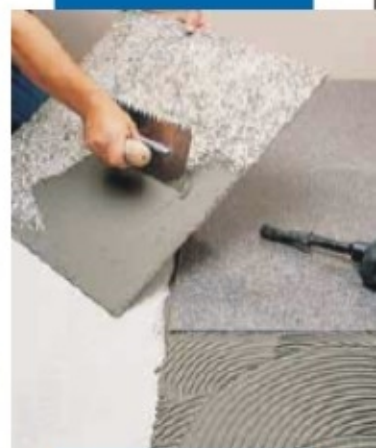
Thi công đá granite tổng hợp bằng Granirapid màu xám
