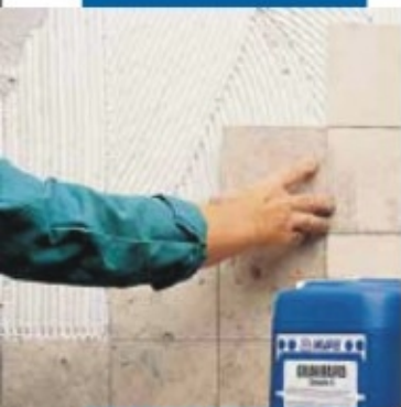
Dán đá cẩm thạch Jura bằng Granirapid màu xám
