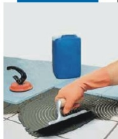
Thi công gạch trên gạch ceramic bằng Granirapid màu xám
