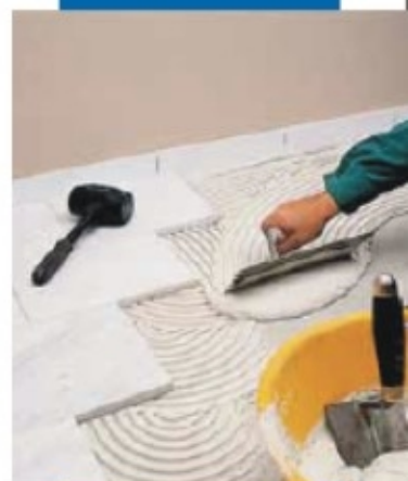
Thi công đá cẩm thạch Cakrara trắng bằng Granirapid màu trắng
