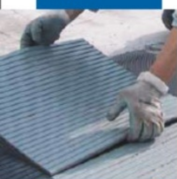
Dán tấm cao su bằng Granirapid
