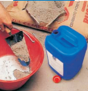
Trộn vữa xi măng với Planicrete SP để ốp lát gạch
