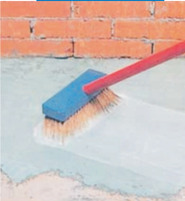
Thi công lớp vữa xi măng loãng pha với Planicrete SP
