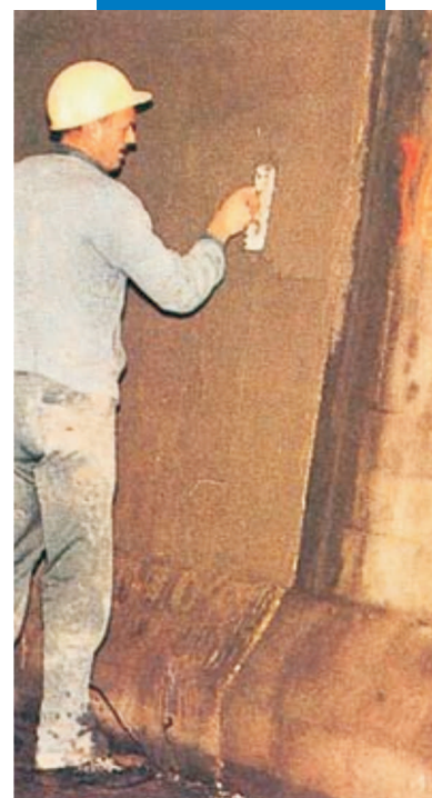
Thi công vữa xi măng với Planicrete SP
