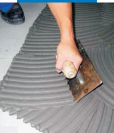
ỐP LÁT GẠCH Dùng bay răng cưa thi công vữa kết dính lên bề mặt đã được chuẩn bị. Mỗi lần thi công không nên trải quá 1 m 2
