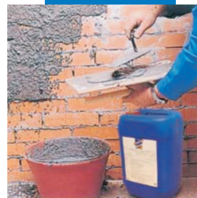
Trát lớp vữa lòng với Planicrete SP
