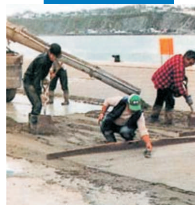
Thi công sàn bê tông với Planicrete SP
