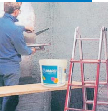
Trộn Planicrete SP với vữa để trát tường
